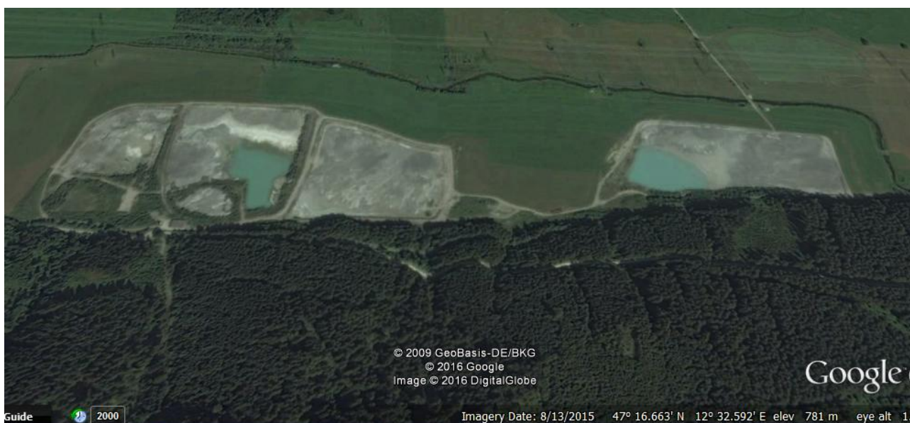
Stockage de stériles de Mittersill le 13 août 2015 (Google Earth)
