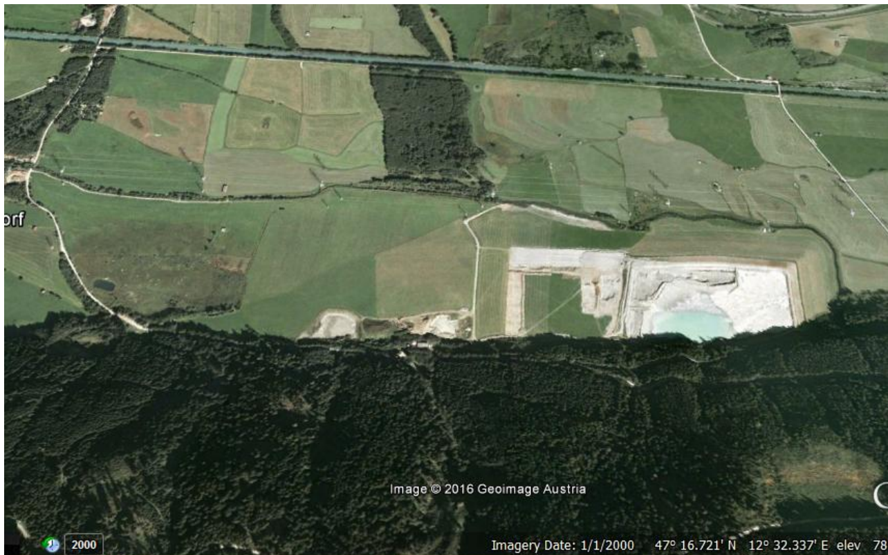
Stockage de stériles de Mittersill en 2000 (Google Earth)
