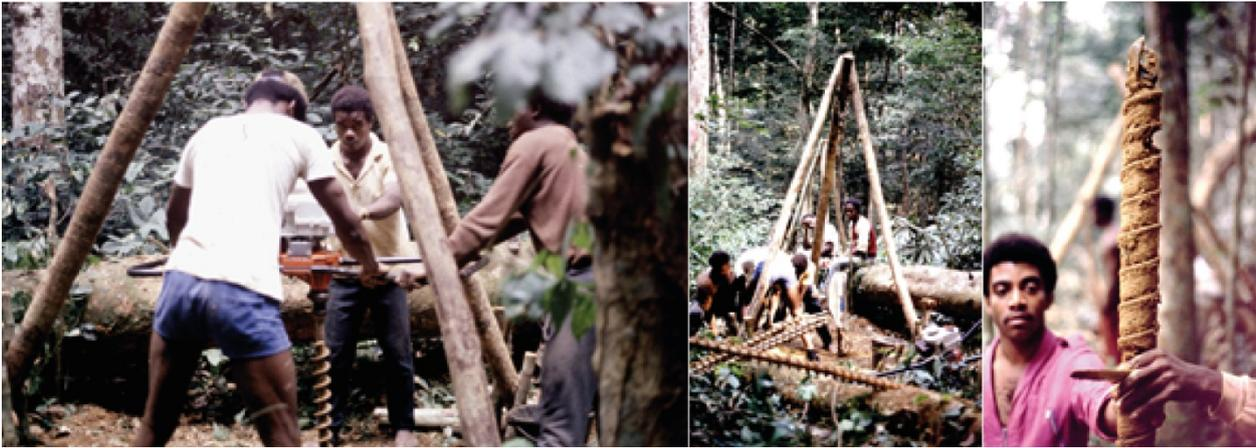
Figure 1 : Vues d'un chantier de sondage à la tarière de profondeur 20 m au Gabon (Cliché : Pol Urien, BRGM).
