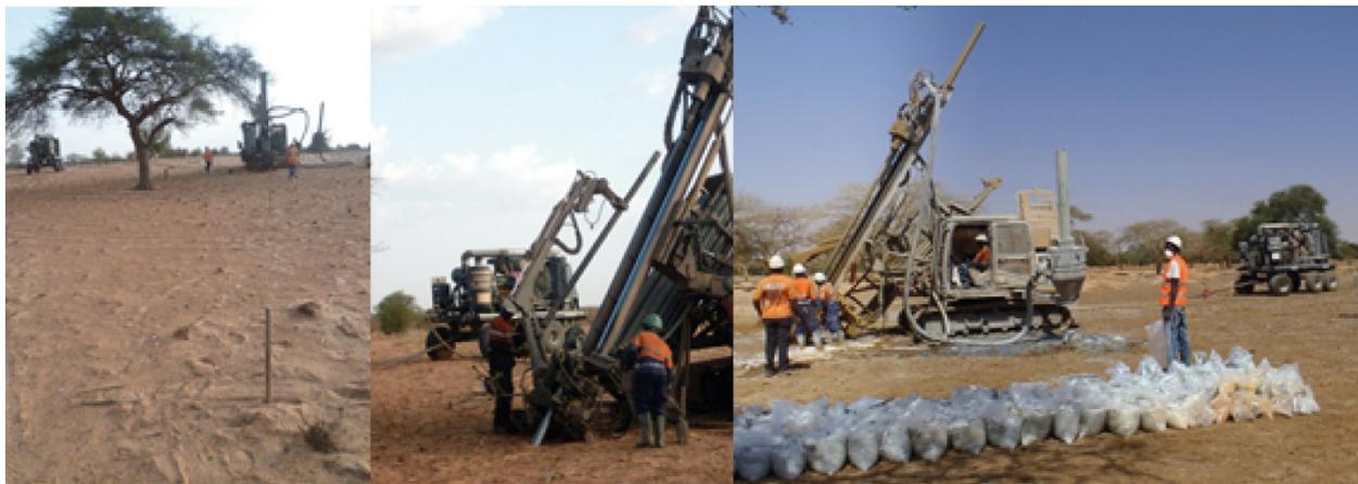
Figure 3. Gauche : Alignement des sondages prévus le long d'un profil de sondages RC. Centre : Manipulations sécurisées avec un bras hydraulique des lourdes tiges d'un sondage RC. Droite : Alignement des cuttings produits par un sondage RC avec le compresseur en arrière-plan (Clichés : 'Essakane 2011 IAMGold - Pol Urien, BRGM).
